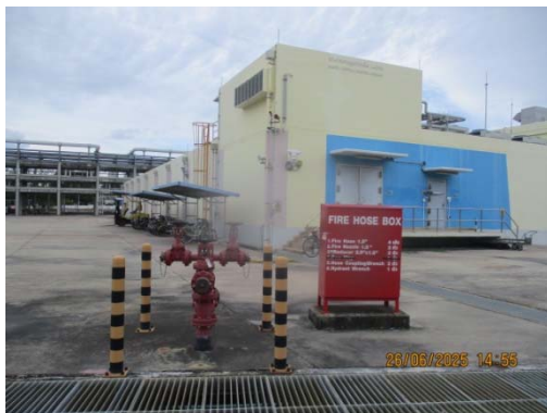
รูปที่ 49 Hydrant และ Hose box
