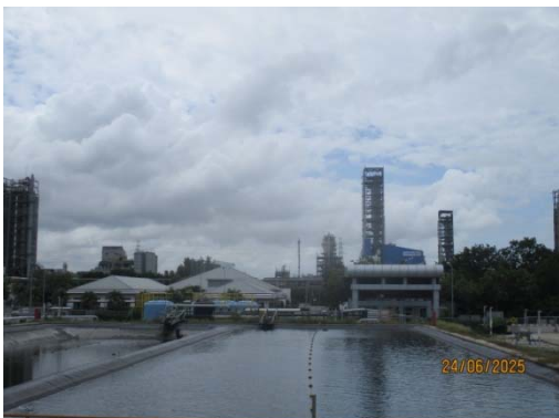
รูปที่ 14 บ่อพักน้ำทิ้งที่ผ่านการบำบัดแล้ว ของโรงงานอีเทนแครกเกอร์
