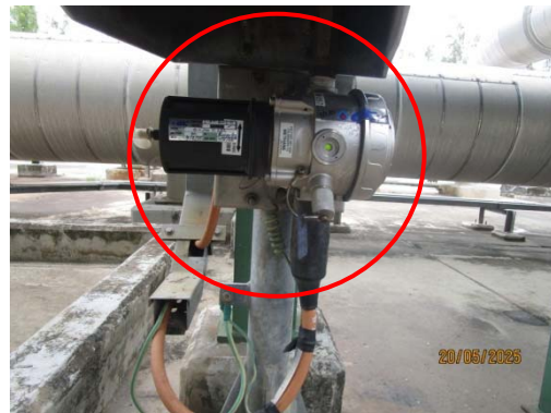
รูปที่ 42 Gas Detector บริเวณถังเก็บสารเคมี และสารไวไฟ
