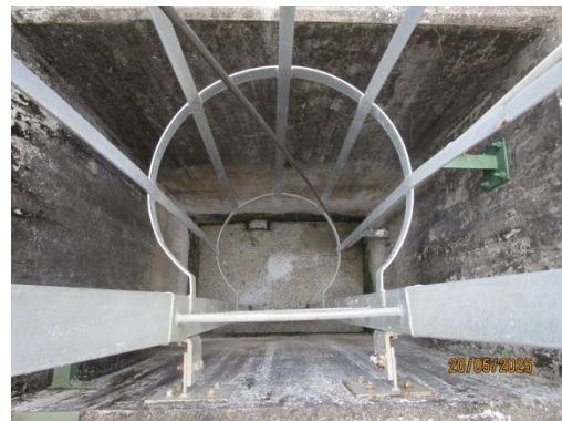
รูปที่ 13 บ่อรวบรวมน้ำ (Collection Sump)
